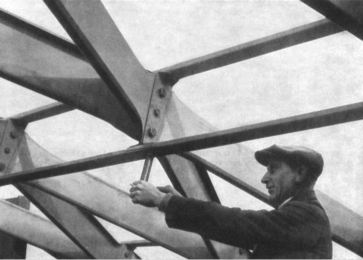
Patent: Hugo Junkers auf Basis des Systems von Friedrich Zollinger hier: Montage des modularen Stahllamellensystems, welches auch für Garagen, Flugzeughangars, Sportbauten und Bahnhöfe in alle Welt von hier aus exportiert wurde
