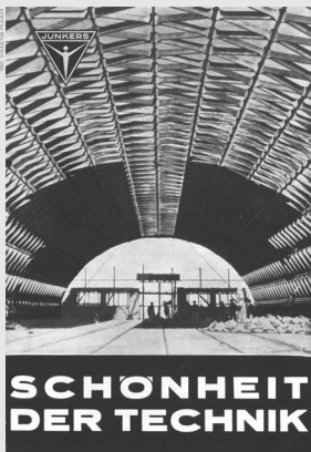
Junkers - Werbeplakat im Zeitgeist der 1920-er Jahre, zeigt ein bauzeitliches Bild der Stahllamellenhalle. Die Halle ist heute in sanierungsbedürftigem Zustand.
