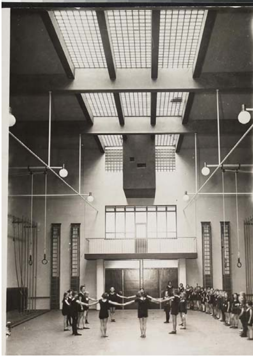
depicted item: Altstädter Schule, central hall source: Haesler-Archiv im Stadtarchiv Celle date: 1928
